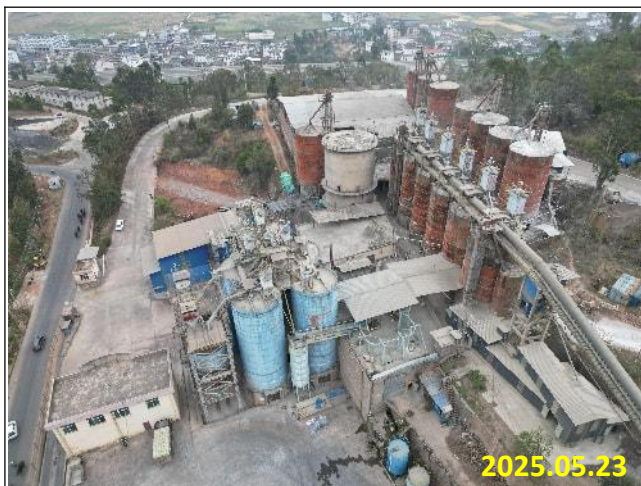
项目生产区现状
