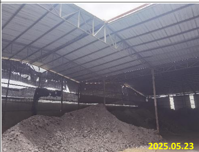
项目区东北侧现有原料堆棚
