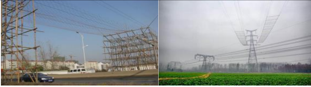
图 2-2 线路工程临时跨越形式示意图
