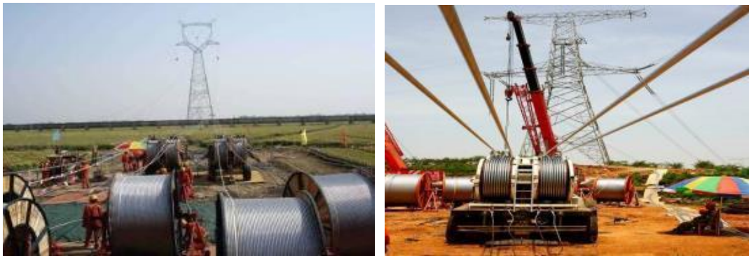
图 2-1 牵张场布置形式示意图
